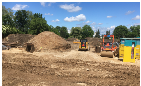
Bodensanierung (Bild: Rapp Infra AG)
