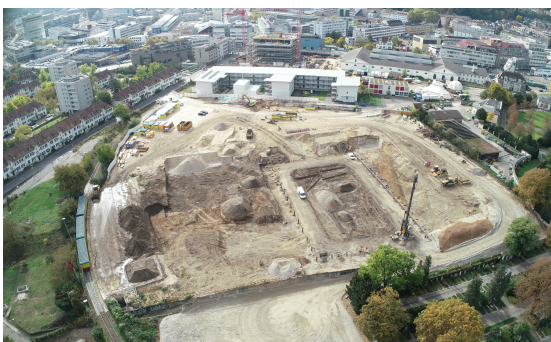
Bodensanierung (Bild: Eberhard Unternehmungen)
