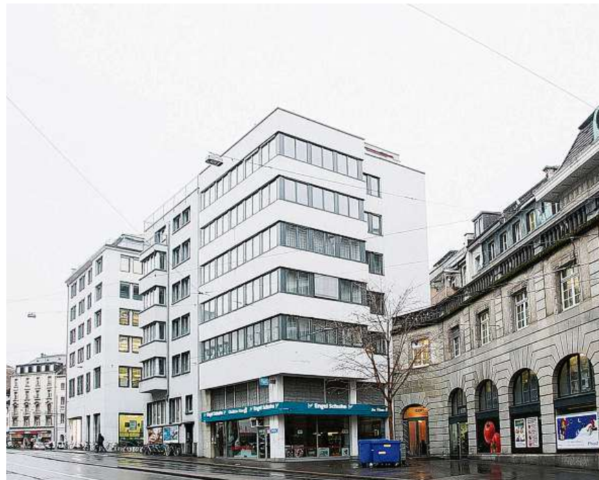
Mitten in der Stadt. Die beiden neueren Häuser neben der ehemaligen Börse an der Spiegelgasse sollen für das neue AUE abgerissen werden. Foto Nicole Pont
